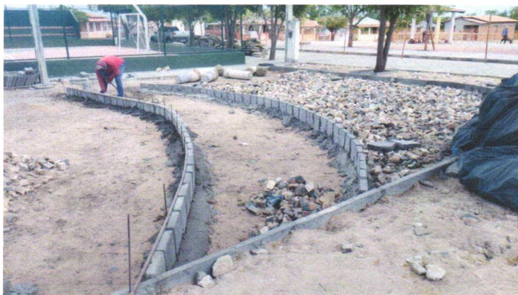
Foto 01 - ASSENTAMENTO DE GUIA (MEIO-FIO) EM TRECHO RETO, CONFECCIONADA EM CONCRETO PRÉ-FABRICADO, DIMENSÕES 100X15X13X20 CM (COMPRIMENTO X BASE INFERIOR X BASE SUPERIOR X ALTURA), PARA URBANIZAÇÃO INTERNA DE EMPREENDIMENTOS. AF_06/2016_P
