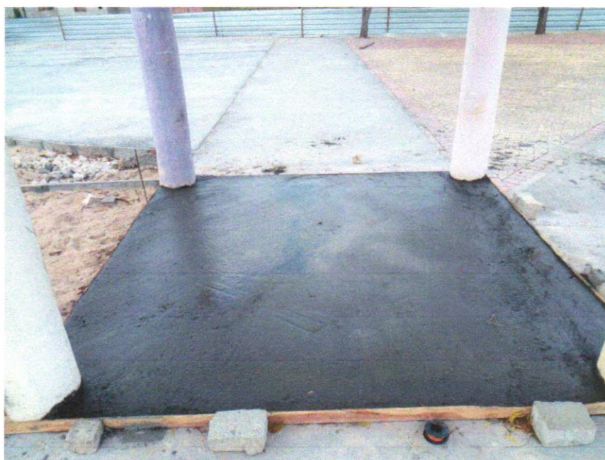
Foto 04 - PAVIMENTAÇÃO EM CONCRETO, COM ESPESSURA DE 7 CM, COM ACABAMENTO FEITO UTILIZANDO ALISADORA DE CONCRETO (HELICOPTERO), INCLUIDO TELA DE AÇO SOLDADA NERVURADA CA60, Q196 (3,11 KG/M2), DIAMETRO DO FIO 5.0 MM, LARGURA = 2,45 M, ESPAÇAMENTO DA MALHA = 10 X 10 CM, JUNTA DE DILATAÇÃO EM PVC A CADA 2,00 M, CONCRETO FCK = 20 MPA
