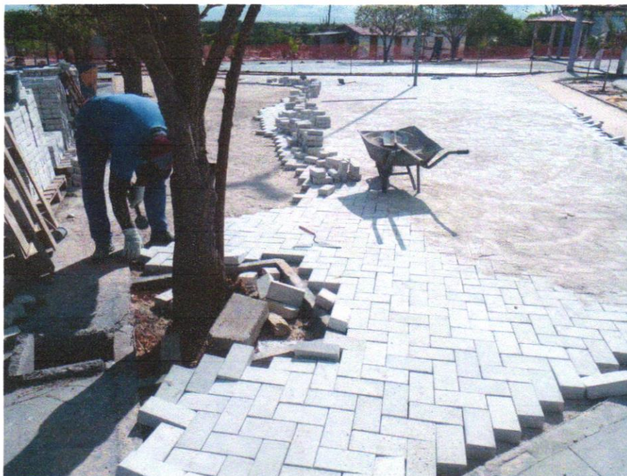
Foto 05 - Pavimentação em bloco de concreto vibroprensado, intertravado, cor natural, 10x20cm, e=6cm, 46un/m 2 , NBR9781, Fck(min)=35MPa, sob coxim areia grossa compactada c/ placa vibratória, e(comp.)=6cm, rejuntado c/areia fina.
