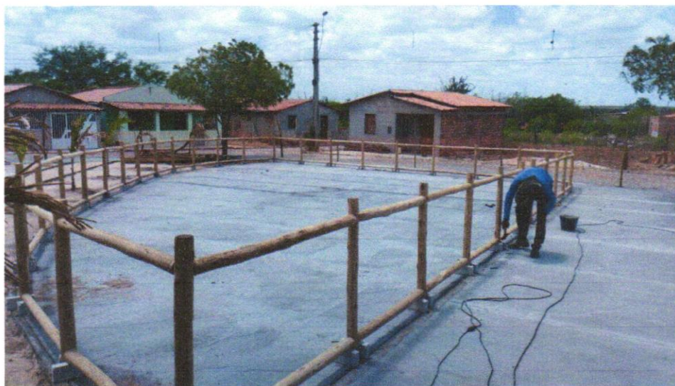
Foto 07 - FORNECIMENTO E MONTAGEM DE CERCA DE PROTEÇÃO EM EUCALIPTO CLOEZIANA TRATADO A BASE DE CCA EM AUTOCLAVE, COM APLICAÇÃO DE STAIN NA COR NATURAL COM DUPLO FILTRO SOLAR, DIAMETRO DO EUCALIPTO DE 6 A 8 CM, COM ANTI-RACHA NA EXTREMIDADE, FECHAMENTO COM TELA DE ALAMBRADO FIO Nº 12 REVESTIDO DE PVC, MALHA 2.1/2 X 2.1/2", FIXADO COM FIO Nº 14 REVESTIDO EM PVC, MÓDULO MEDINDO 1,50 X 1,00M, PARAFUSOS GALVANIZADOS COM TRAVAMENTO CLICKFIX, CONFORME PROJETO
